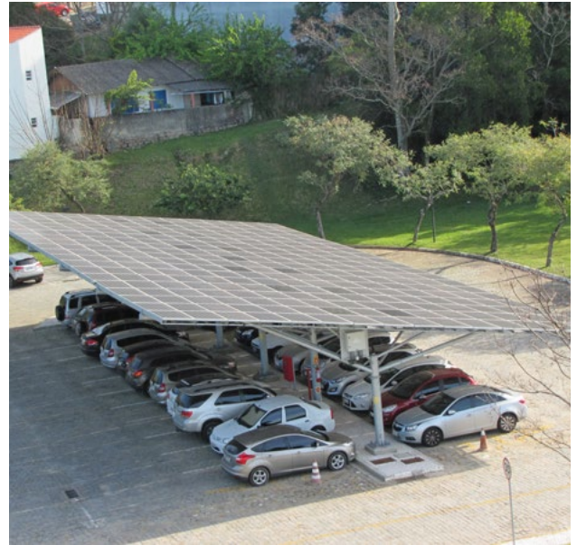
Figura 4. Exemplo de estacionamento solar
